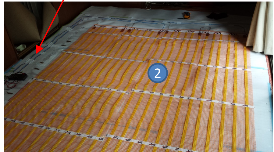
电源导线布置合理
