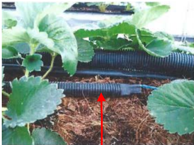
非晶态加热带放置在波纹管内
